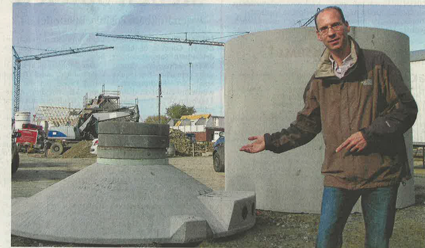
Der Eisspeicher aus Beton ist das Herzstück der Anlage. Hier zeigt Jens Drüner den Deckel (l.) und den Bottich vor dem Einbau ins Erdreich. Der Speicher wird später mit 10 000 Litern Wasser befüllt.
